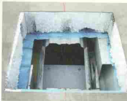
Eine der 400 Dachdurchdringungen.
